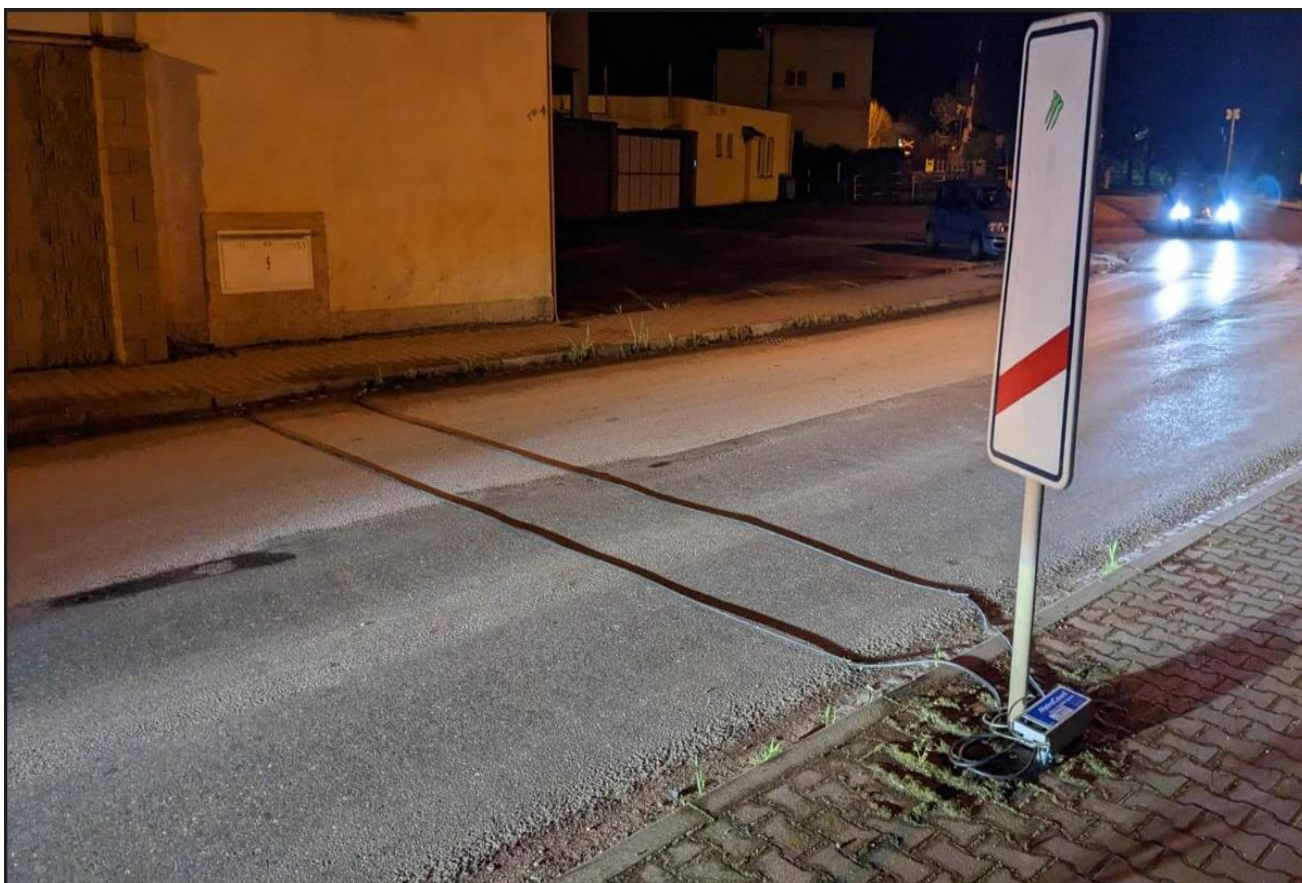
Obrázek 3: měřená komunikace s uloženým měřícím zařízením
